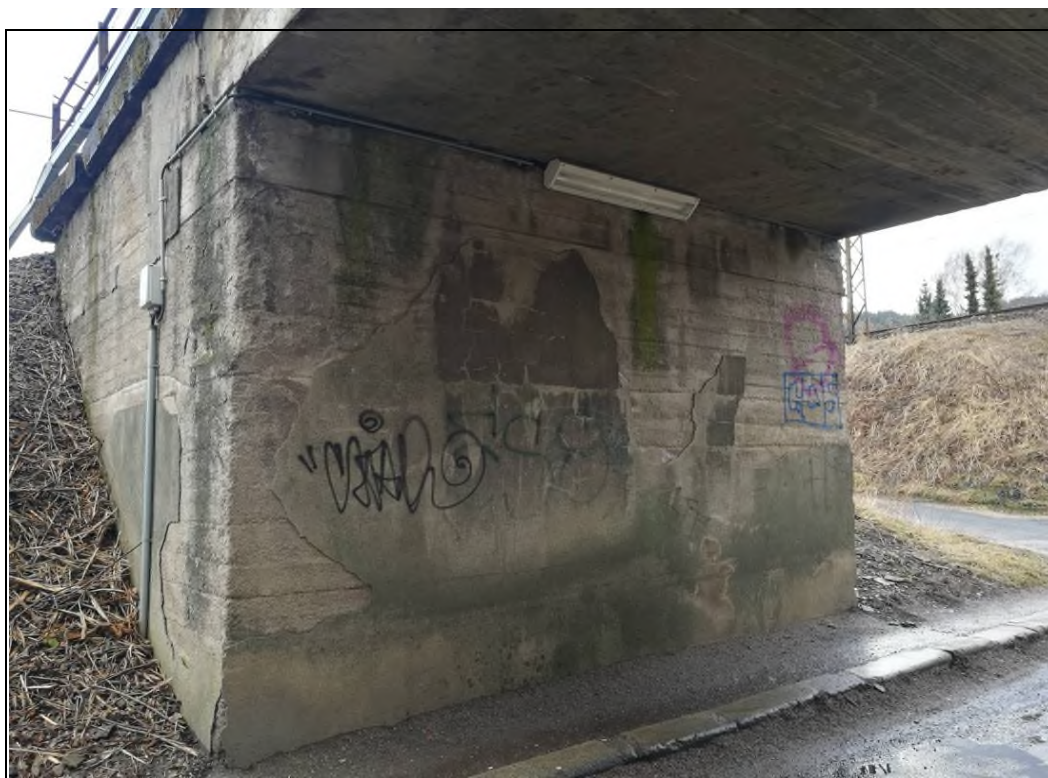
Obr. č. 4 - pohled na opěru Č. Třebová - opady omítky v líci
