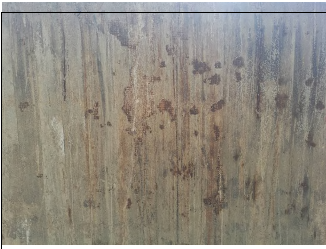
Obr. č. 3 - pohled na spodní líc NK – opady omítky odhalující rabinové pletivo a ocelové pruty konstrukční výztuže
