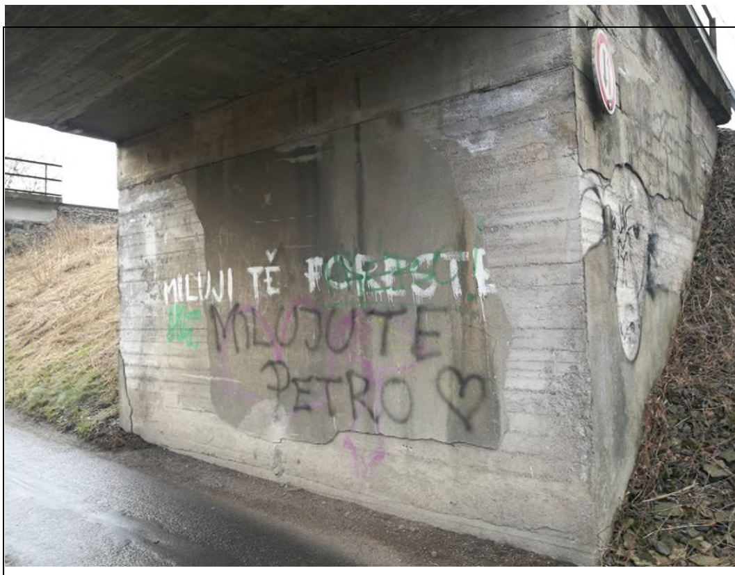
Obr. č. 5 - pohled na opěru Ústí - opady omítky v líci
